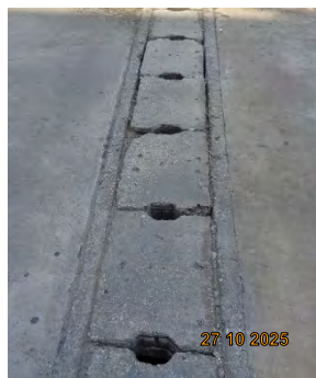
ร่างระบายน้ำฝนไม่ปนเปื้อน
