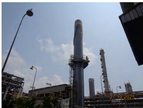
ภาพที่ 2.2-1 ปล่องระบายอากาศ Regenerative Thermal Oxidizer (RTO)
